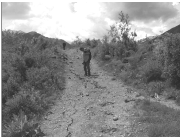
Рис. 3. Оползневые, обвальные процессы и трещины в грунте, возникшие при Тавильдаринском землетрясении 12 мая 2012 г. в долине р. Обихингоу
