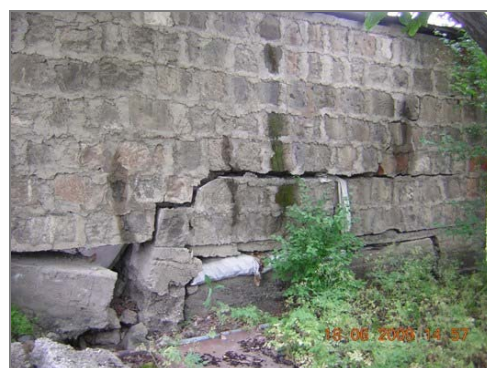
Рис. 6. Пример трещин, образовавшихся в с. Вохчаберд ( \Delta=9 км) [9]
