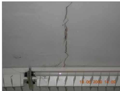
Рис. 5. Пример трещин, образовавшихся в с. Зовк ( \Delta=5 км) [9]
