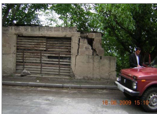
Рис. 6. Пример трещин, образовавшихся в с. Вохчаберд ( \Delta=9 км) [9]
