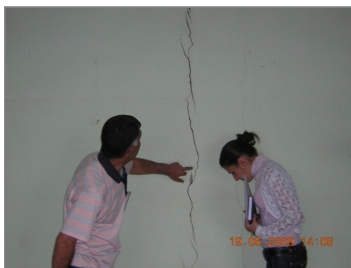
Рис. 5. Пример трещин, образовавшихся в с. Зовк ( \Delta=5 км) [9]
