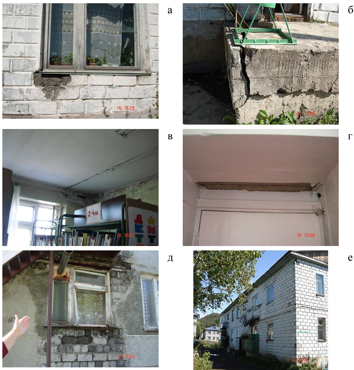
Рис. 3. Примеры повреждений в пос. Чапланово, вызванные землетрясением 13 сентября 2009 г.: обвалившиеся куски штукатурки (а) и треснувшее крыльцо (б) в здании поселковой Управы, осыпавшаяся штукатурка в помещениях библиотеки (в) и детского сада (г), выпавшее окно и обвалившиеся куски штукатурки на фасаде детского сада (д), поврежденный балкон в жилом доме (е)
