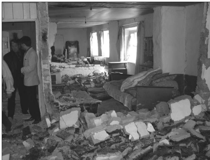
Рис. 4. Фото одного из разрушенных домов в пос. Рыбцех [9]
