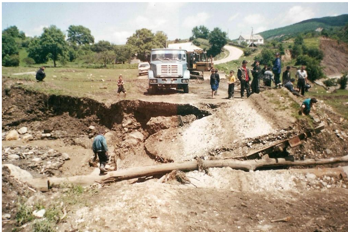
Рис. 6. Последствия Курчалойского землетрясения 11 октября 2008 г. с K_p=14.5 , M_w=5.8 , I_0=7\text{--}8 [68]
