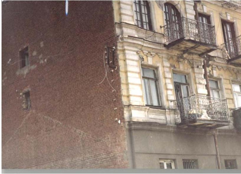
Рис. 2. Сквозные трещины в здании на ул. Пиросмани, 27 (фото В.Г. Папалашвили)
