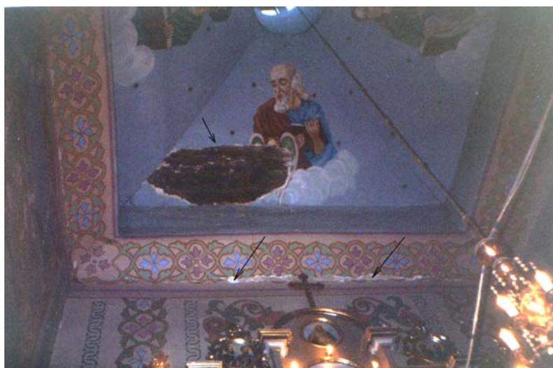
**Рис. 14.** Село Лучка, церковь Введение Богородицы в храм Господний. Стрелками указаны трещины внутри церкви на стыке стены и нефа, а также овальный обвал штукатурки с нефа.
