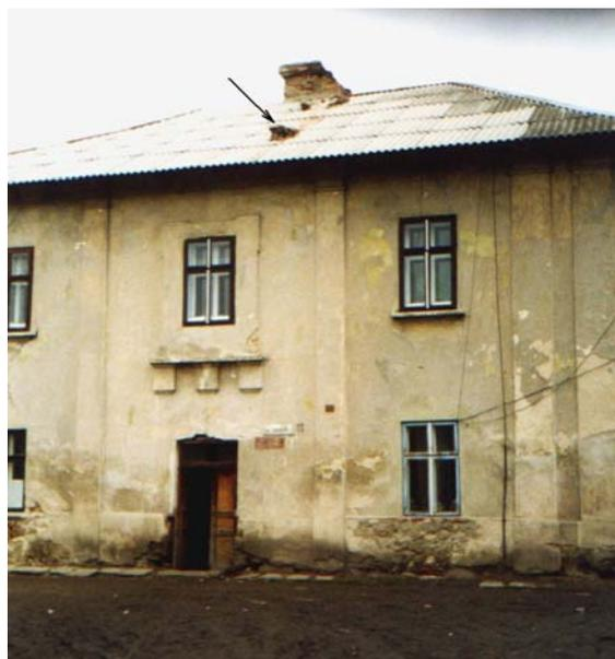
**Рис. 7.** Пгт. Микулинцы, ул. Галицкая, 11. Стрелкой указана упавшая часть дымовой трубы.
