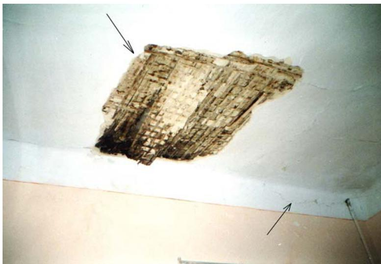
**Рис. 5.** Пгт. Микулинцы, областная физиотерапевтическая больница, второй этаж. Стрелками указаны трещины и отколотая штукатурка на потолке в одном из кабинетов (Фотографии Р.С. Пронишина).
