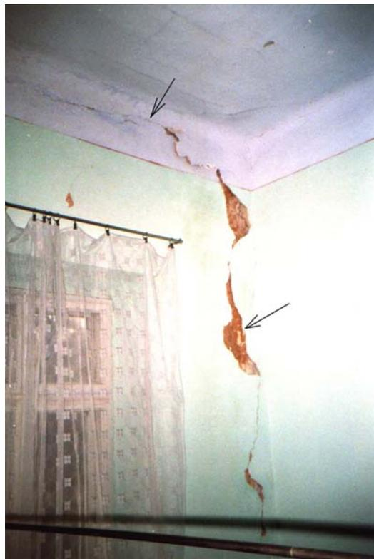
**Рис. 6.** Пгт. Микулинцы, областная физиотерапевтическая больница, второй этаж. Стрелками указаны трещины и отколотая штукатурка на потолке в одном из кабинетов.
