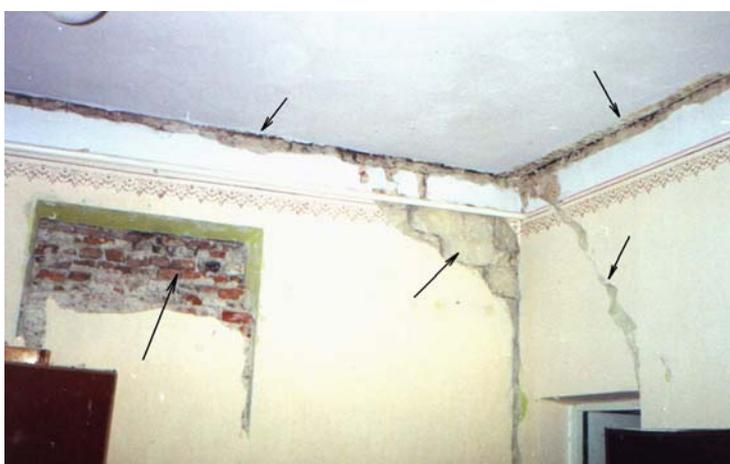
**Рис. 17.** Село Лучка, средняя школа, один из классов. Стрелками указаны трещины в стенах, на стыке потолка и стен, обвал штукатурки из ранее заложеного окна.
