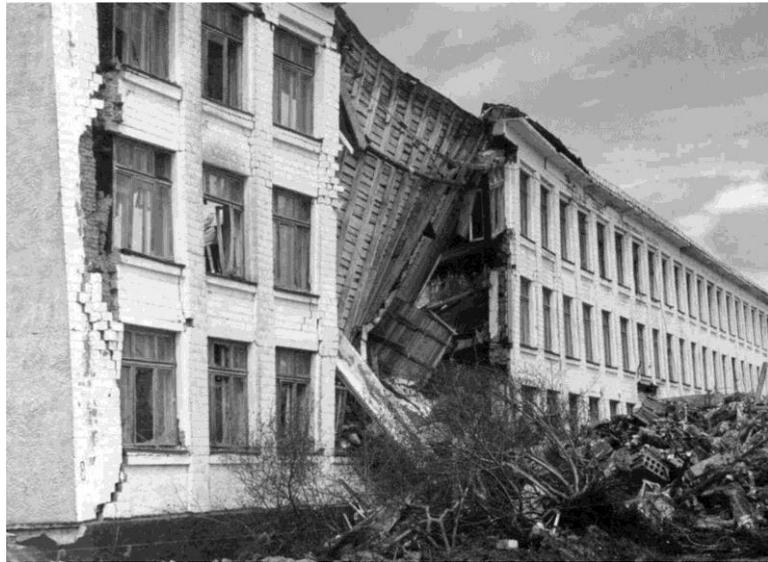
**Фото 2.** Юго-западная часть основного корпуса школы. Видны трещины угловой части здания и повреждения корпуса в районе актового зала, образовавшиеся в результате обрушения его покрытия.
