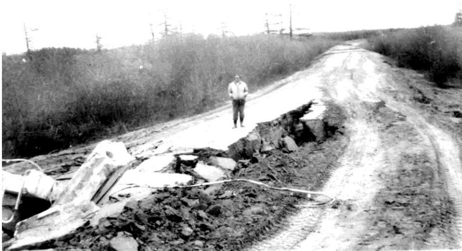
**Фото 8.** Характер разрушения дороги Нефтегорск-Сабо вблизи моста через р. Кадыланы.
