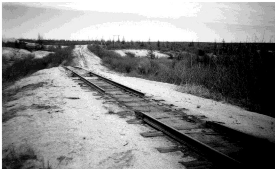
**Фото 7.** Разрыв стыков рельс в районе пересечения узкоколейной железной дорогой Оха-Ноглики долины ручья Железнодорожный.
