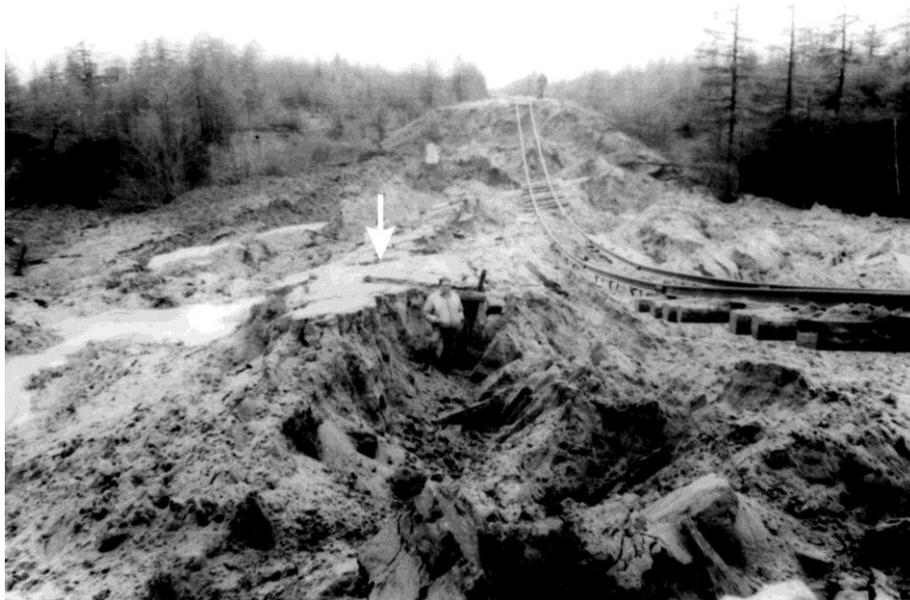
**Фото 6.** Характер разрушения Нефтегорской узкоколейной ж/д ветки вблизи Нефтегорска. Насыпь (отмечена стрелкой) выбита из под ж/д полотна в юго-восточном направлении.
