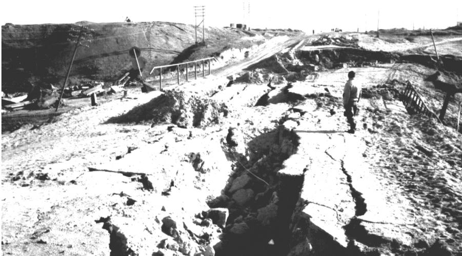
**Фото 9.** Въезд в Нефтегорск с юга: поврежденный землетрясением мост через левый приток р. Кадыланы. Основная причина разрушения моста – неустойчивость высокой насыпи из рыхлых грунтов.
