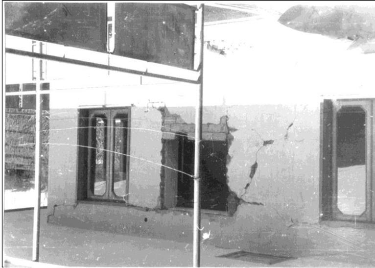
*Рис. 2.* Сквозные трещины в доме Р. Джанишвили
