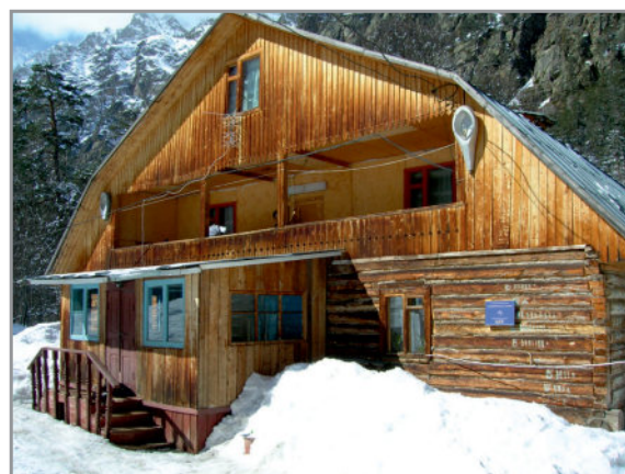
Рис. 2. Производственно-бытовое здание станции в 2008 г.
