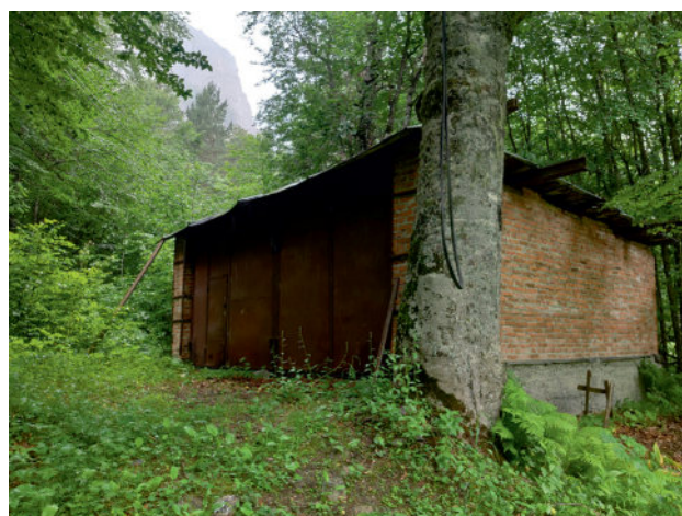
Рис. 8. Здание гаража, где установлена сейсмическая станция в 2023 г.
