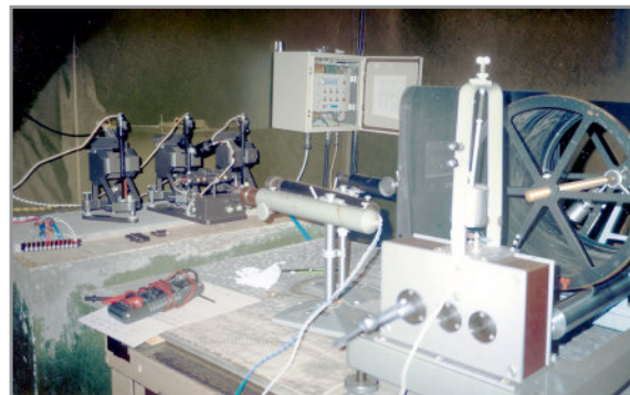
Рис. 3. Комната в производственно-бытовом здании станции с регистрирующей аппаратурой, 2005 г.
